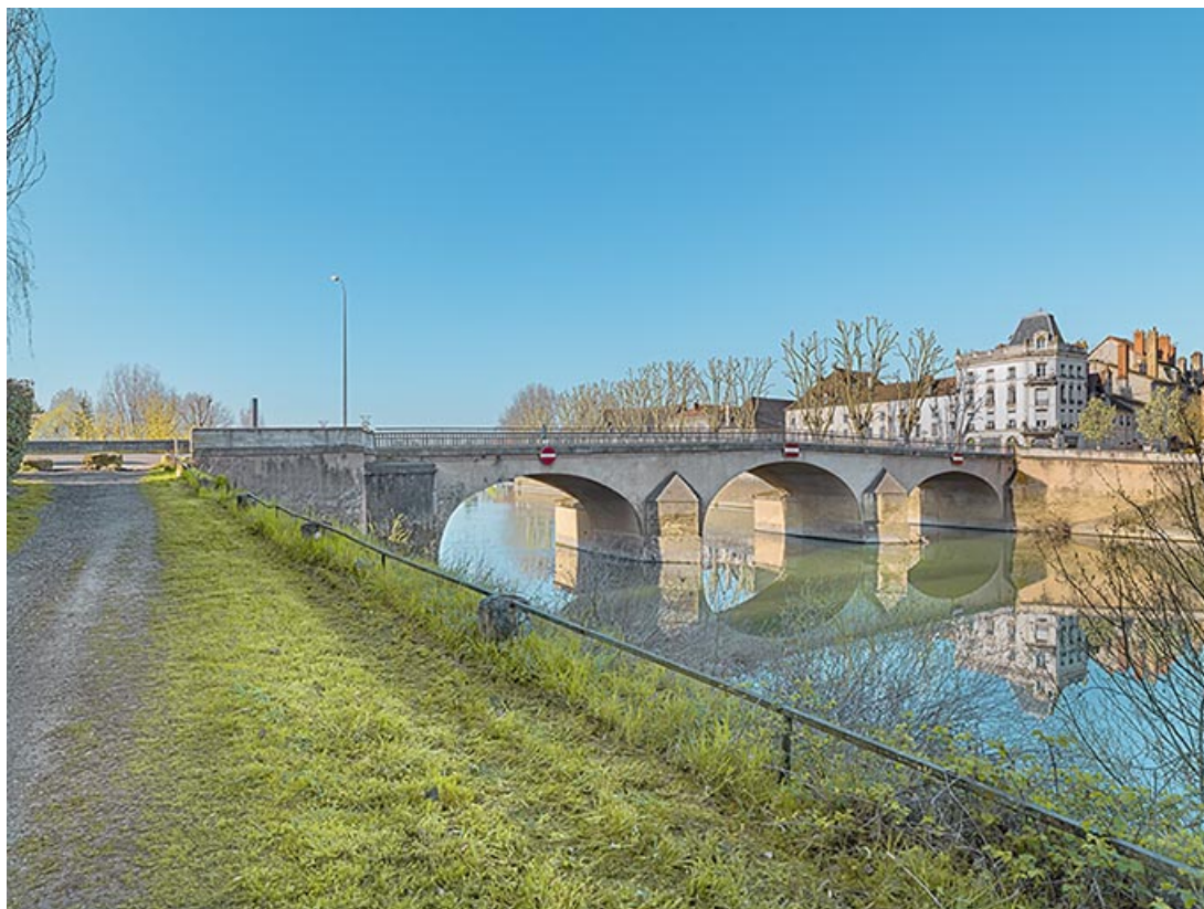
Vue d'ensemble du pont.
