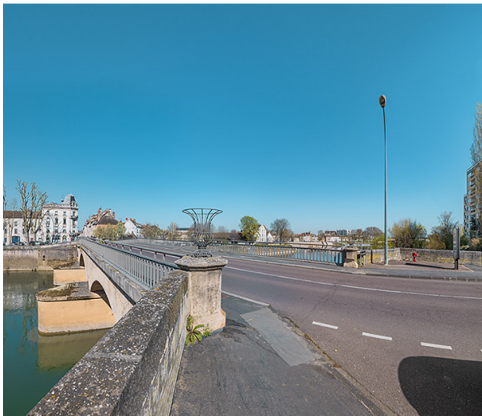
Vue d'ensemble du pont depuis la chaussée.
