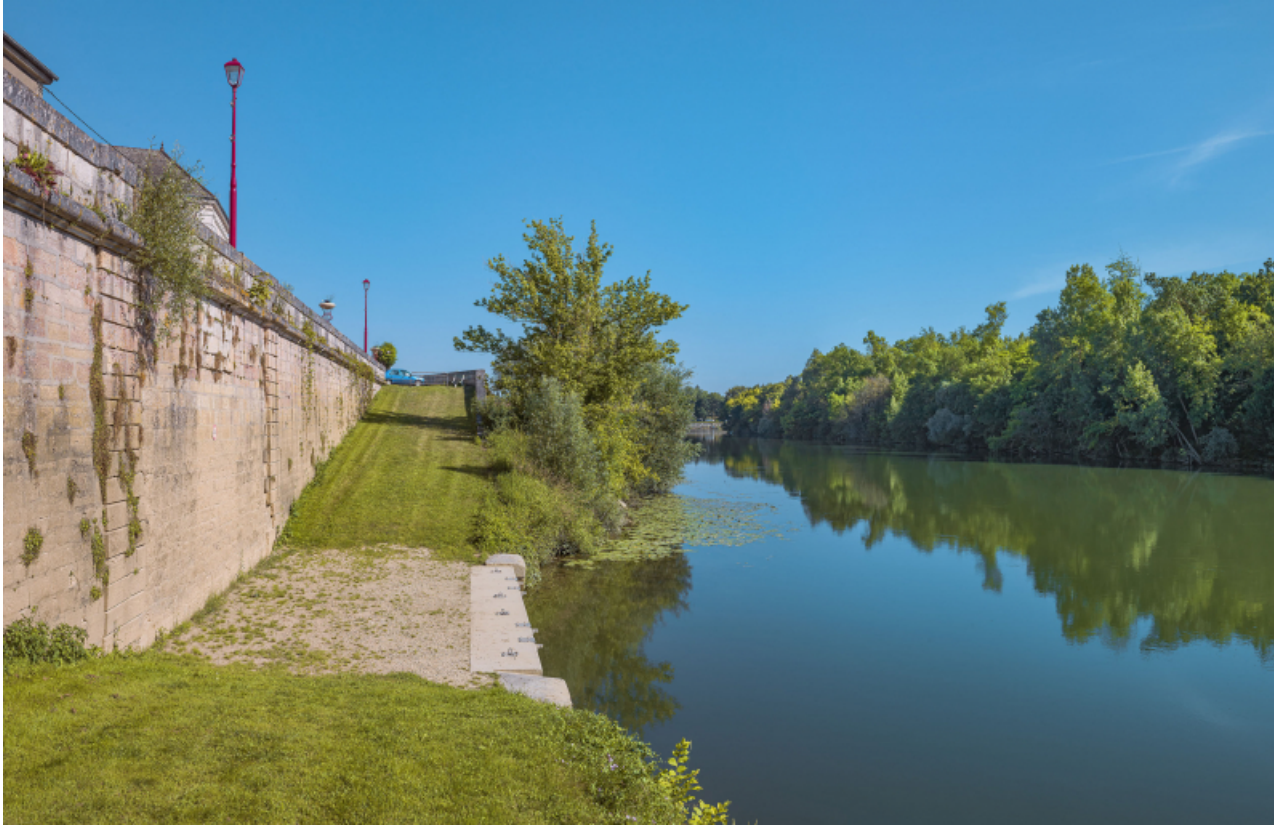
Quais de Verdun : la double rampe.
