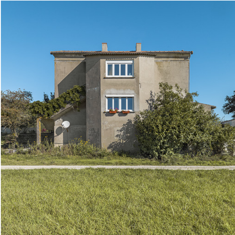
Façade arrière avec l'ajout d'un avant-corps central.
