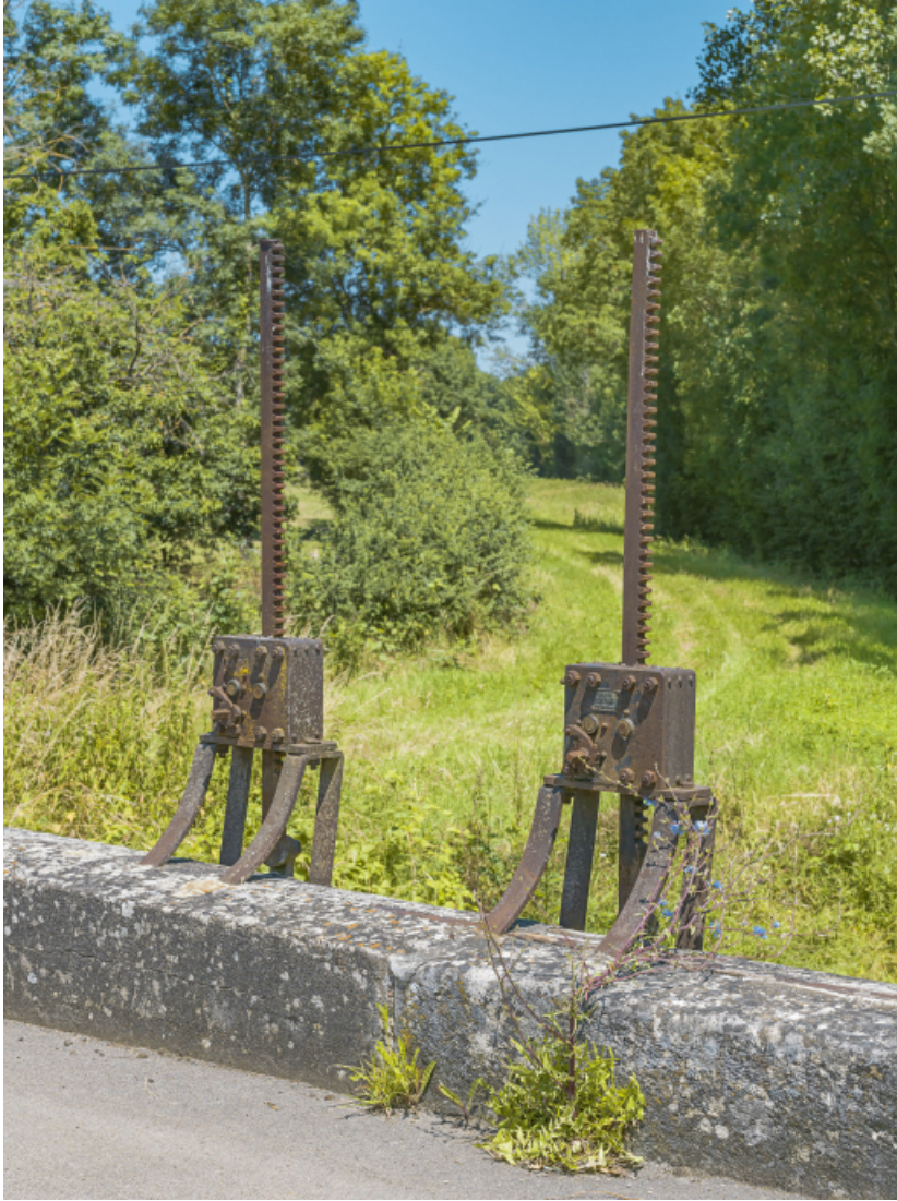
Détail des deux vannes du ponceau.
