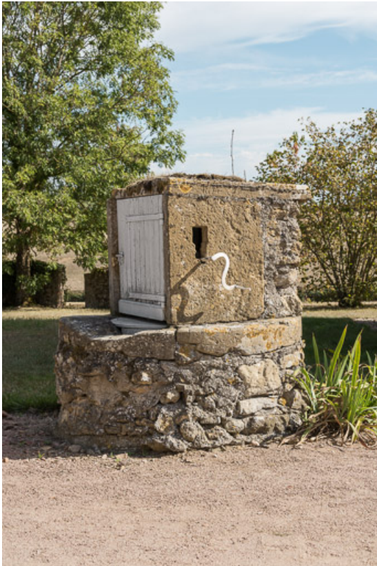
Vue du puits, dans la cour
