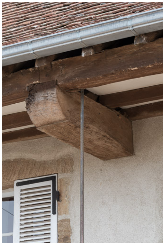
Solive formant encorbellement et permettant, de soutenir le débord de toit destiné à abriter la galerie.
