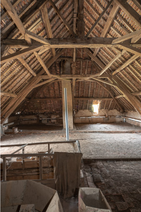
Vue de la charpente de la demeure
