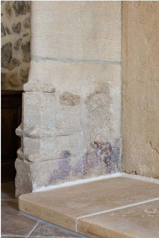
Détail de la cheminée : piédroit avec bases à moulures prismatiques
