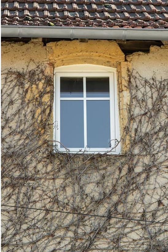
Fenêtre au sommet de la façade (deuxième quart du XVIIIe s.). Le fait que le linteau de la baie soit directement en contact avec les chevrons de la charpente montre qu'il ne s'agit pas de l'ouverture d'origine, qui devait être plus petite.
