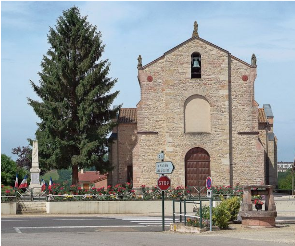
Vue d'ensemble de la façade.
