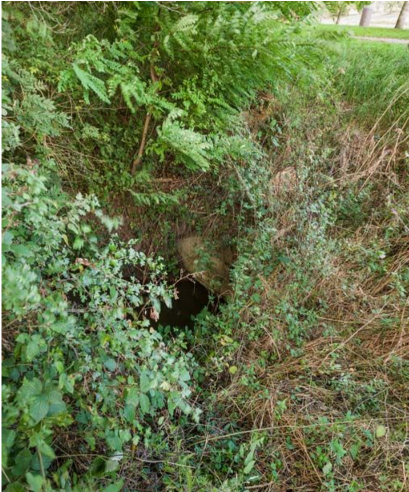
Vue de l'aqueduc.
