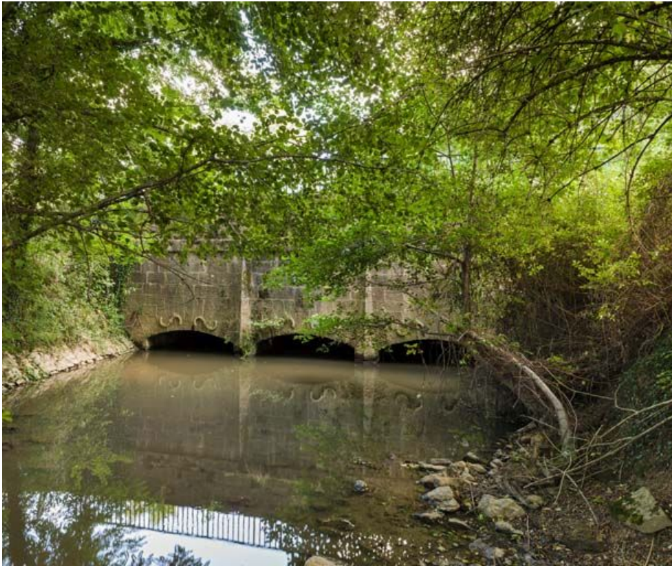
Vue de l'aqueduc.
