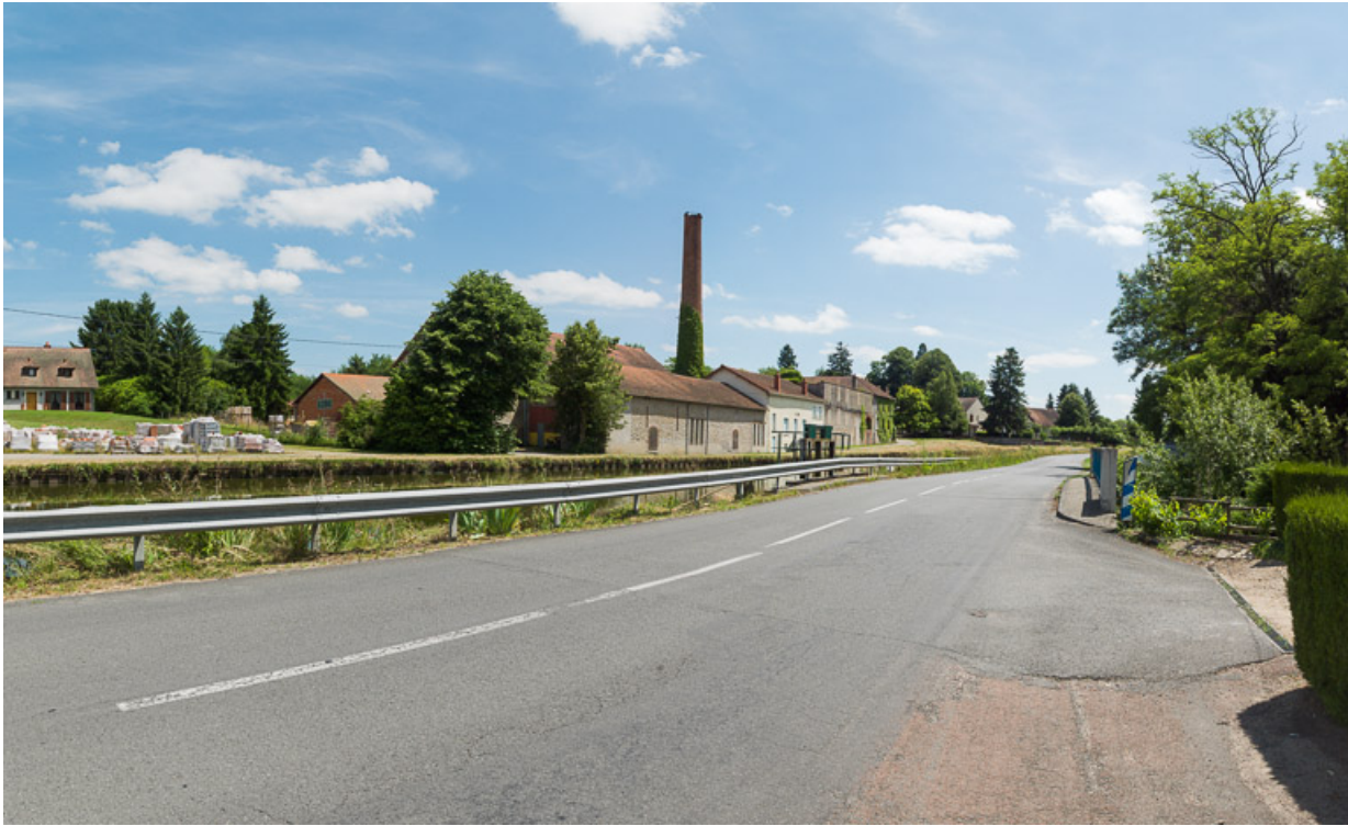
Vue d'ensemble des bâtiments rive gauche.
