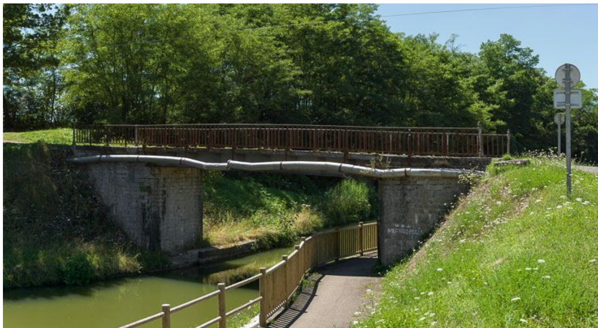
Le pont vu d'amont.
