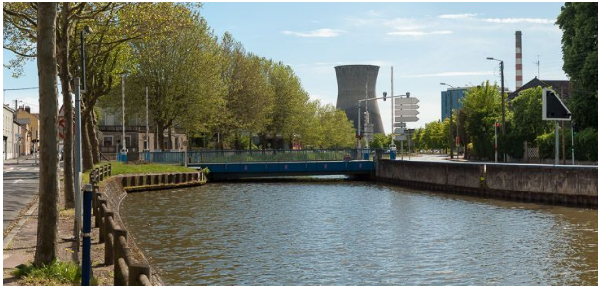
Vue d'ensemble du pont.
