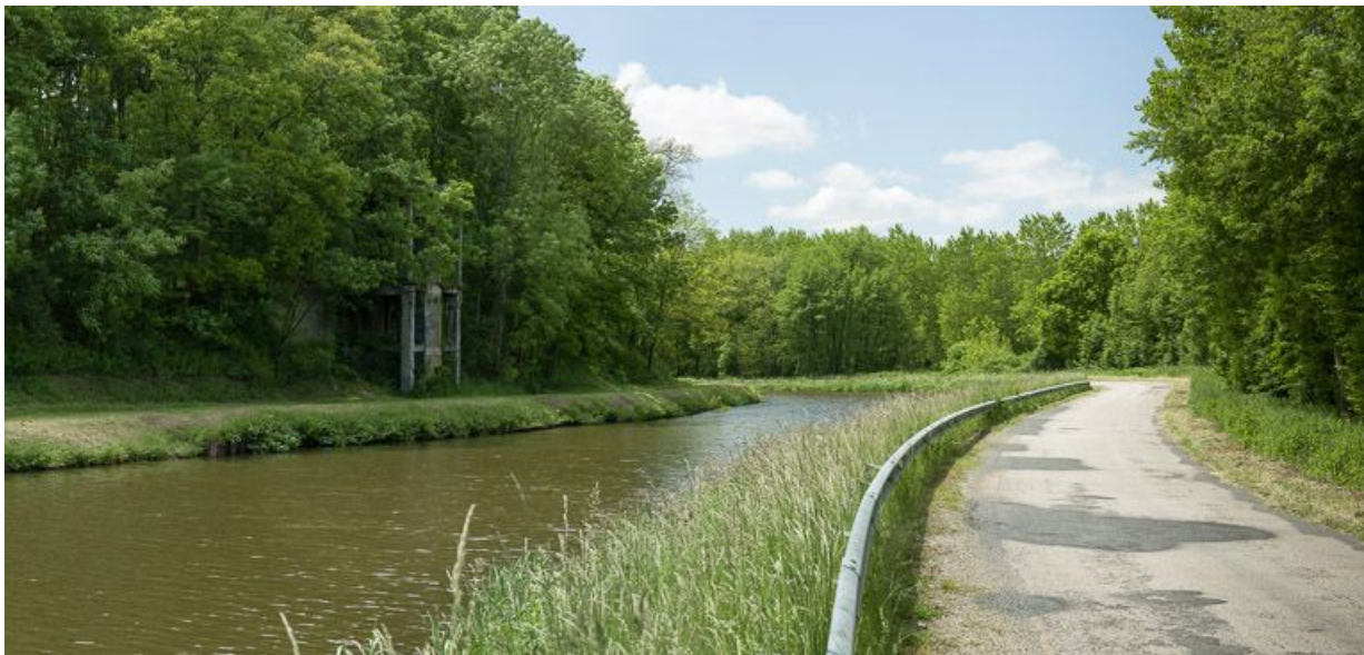
Reste de maçonnerie d'un pont de chargement, rive gauche.
