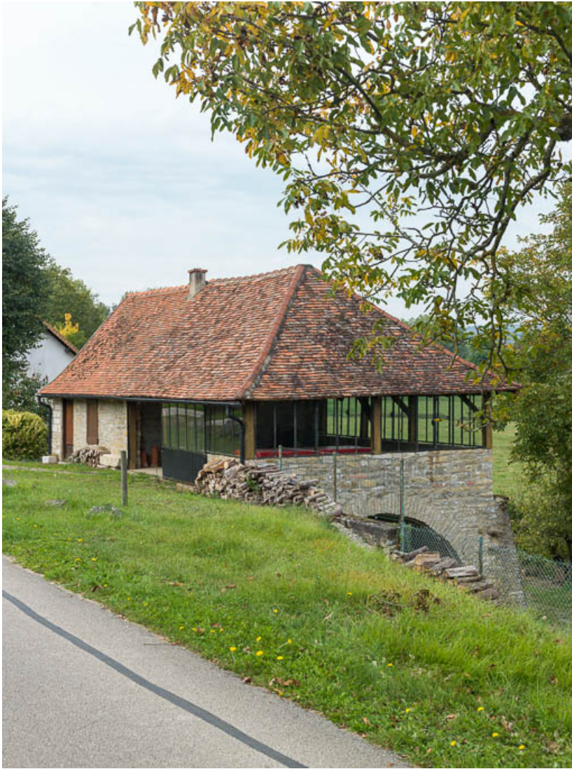
Vue du bâtiment situé en aval.
