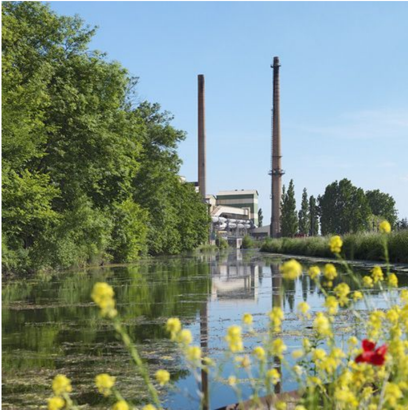
Vue générale de l'usine depuis l'embranchement.
