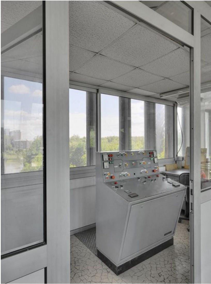
Vue intérieure de l'ancien poste de commande.
