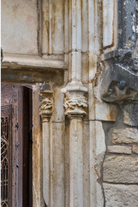
Piédroit, détail de la partie supérieure, droite.
