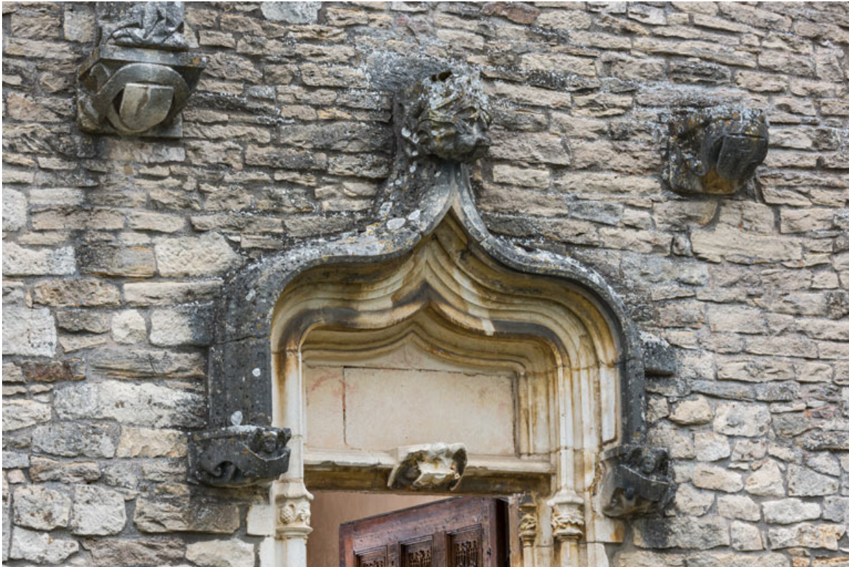
Tympan surmonté d'un arc en accolade.
