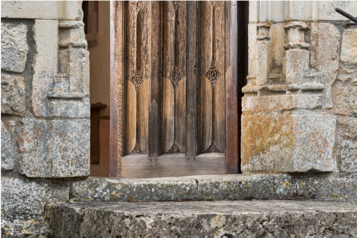
Piédroit, détail de la partie inférieure.
