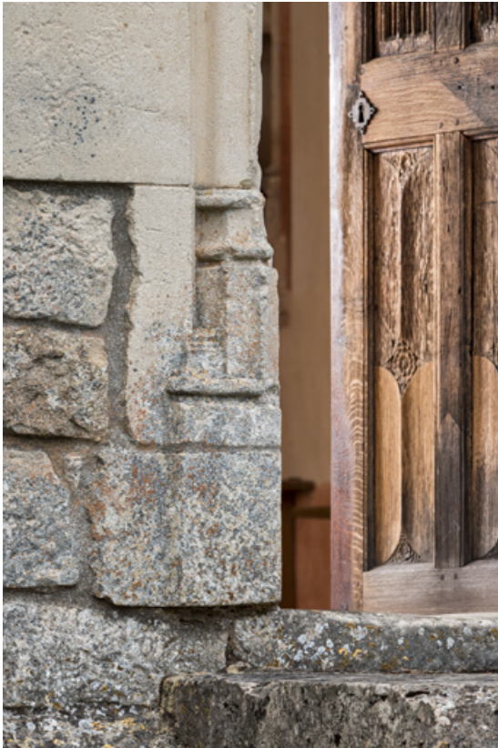
Piédroit, détail de la partie inférieure, gauche.
