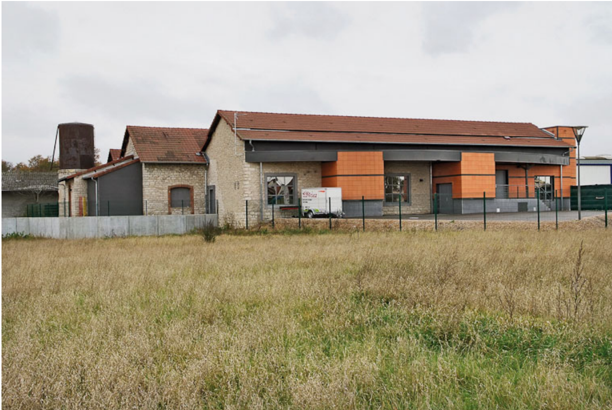
Vue d'ensemble du bâtiment.
