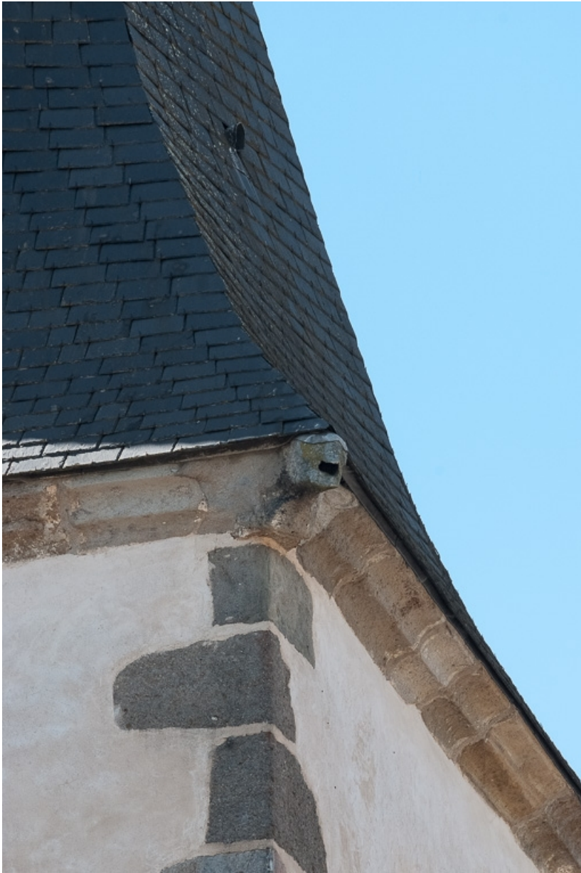
Détail d'une gargouille du clocher.
