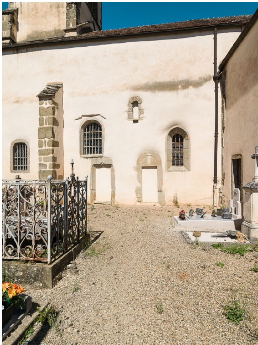
Élévation sud de la nef.
