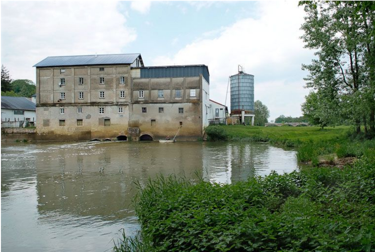
Le moulin vu d'aval.
