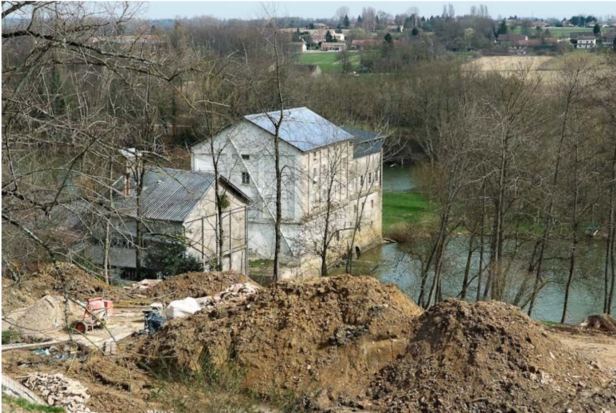
Le moulin vu du dessus.
