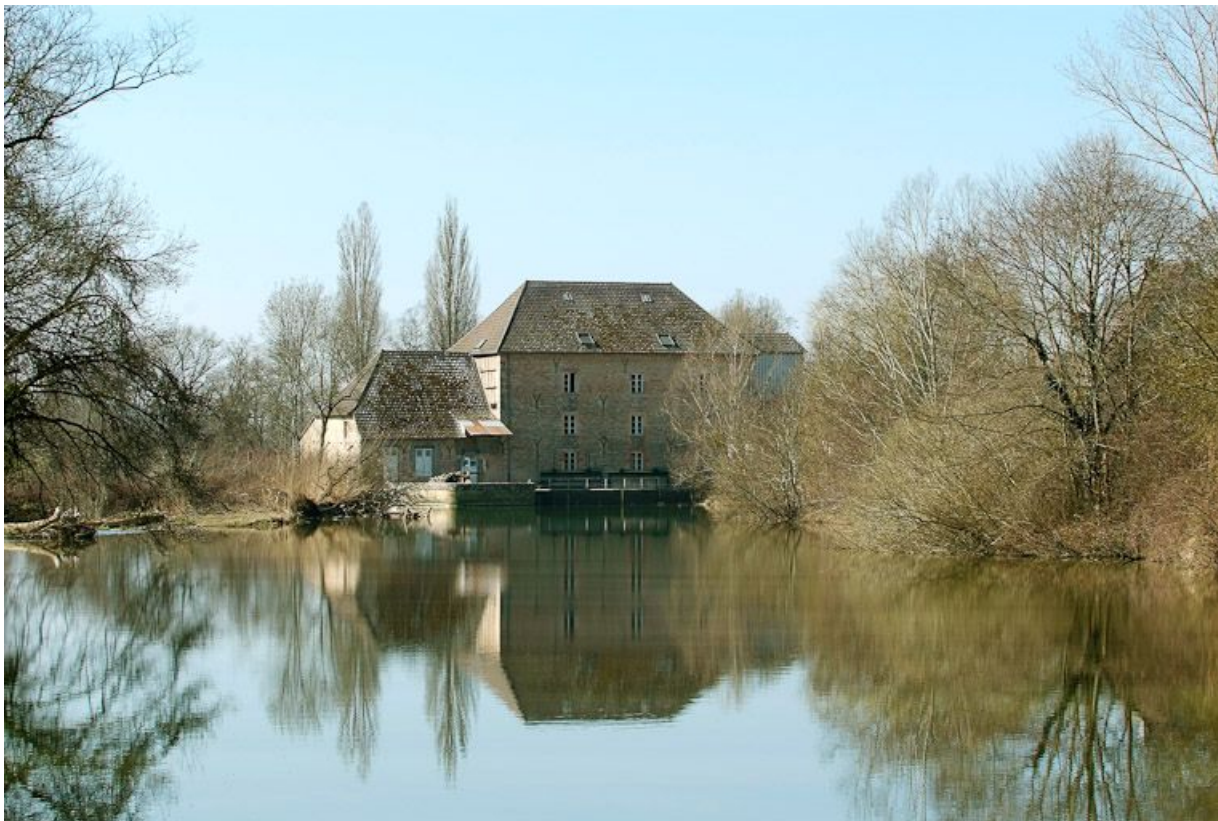
Moulin de Loisy, vu d'amont.
