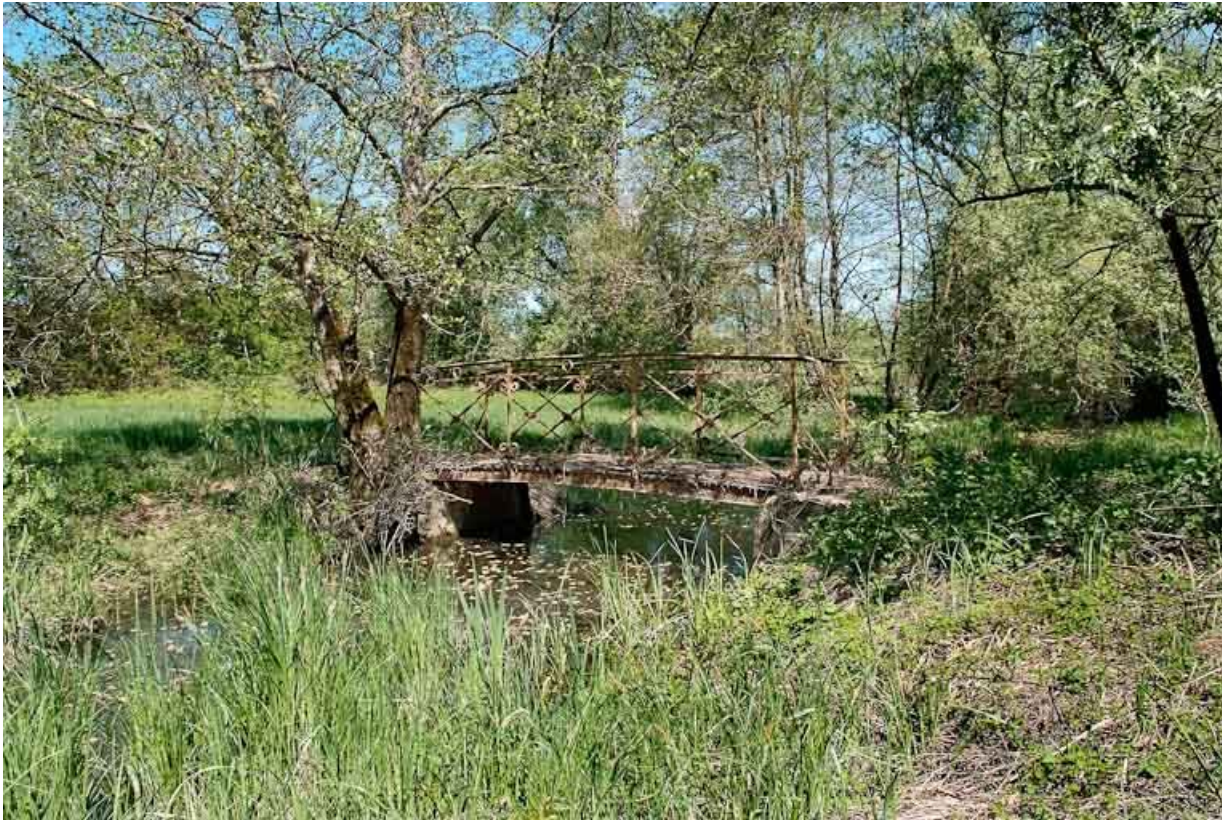
Passerelle métallique sur le Bief Michaud.
