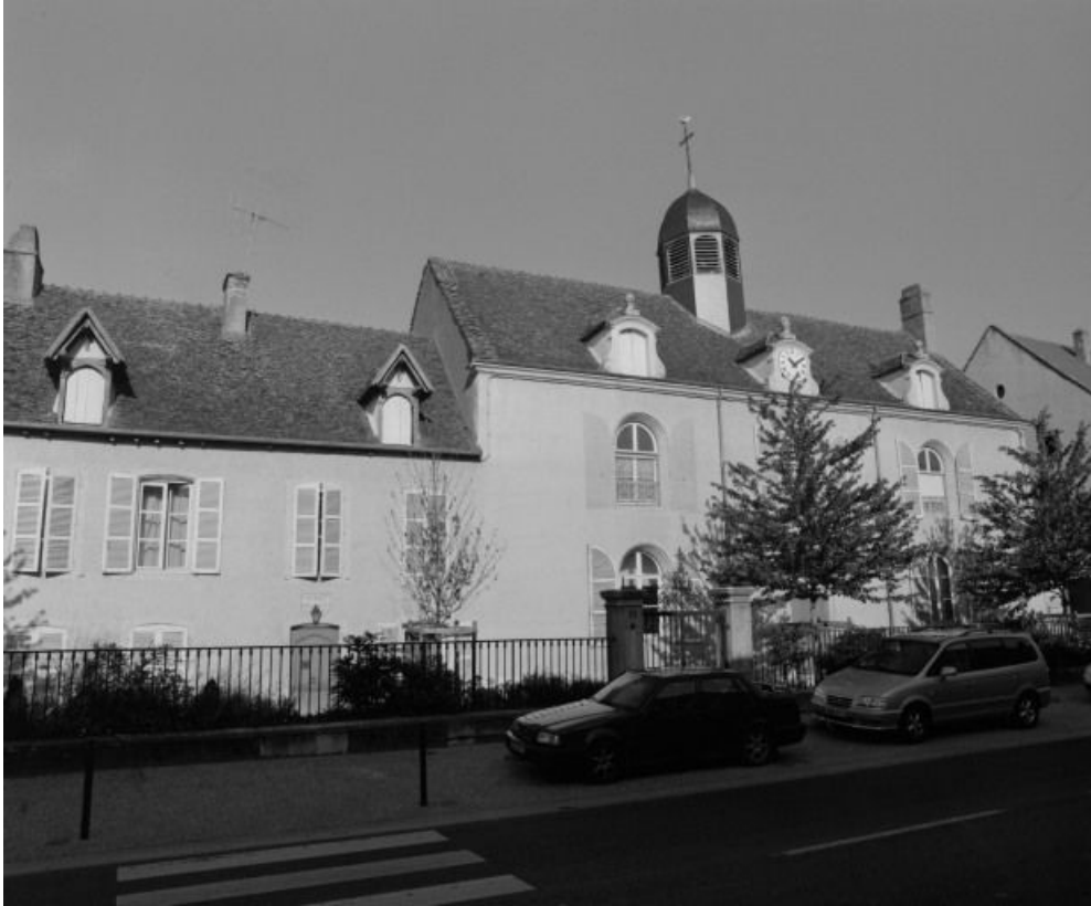
Vue d'ensemble de la façade antérieure.
