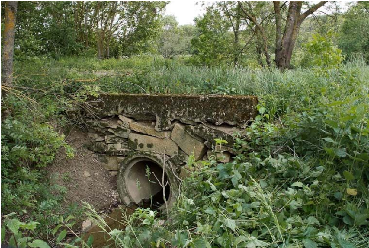
L'aqueduc a été modifié par le passage d'une buse en béton.
