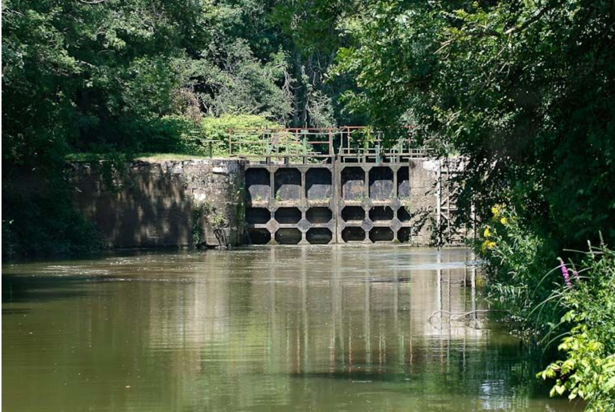
Le sas de l'écluse, vu d'aval.
