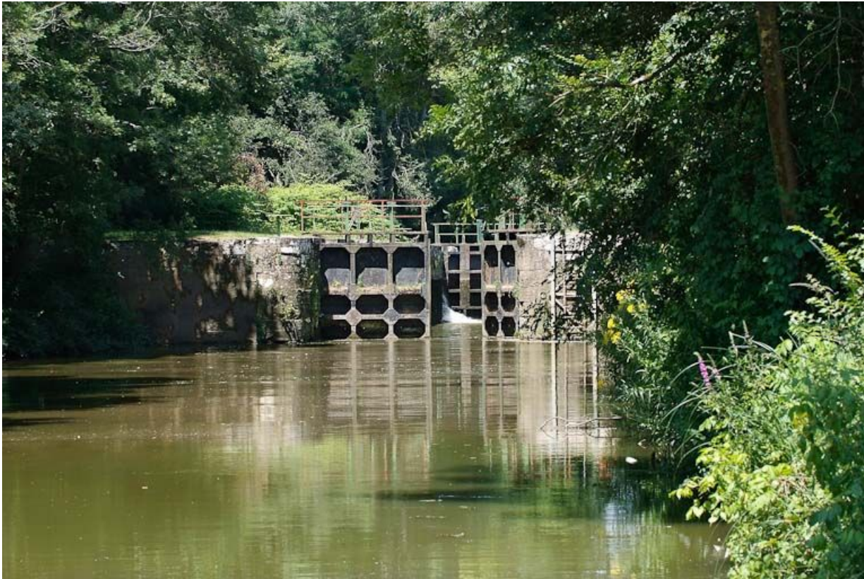
Le sas de l'écluse, vu d'aval.
