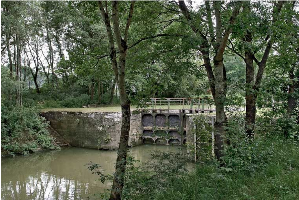
La tête aval de l'écluse.
