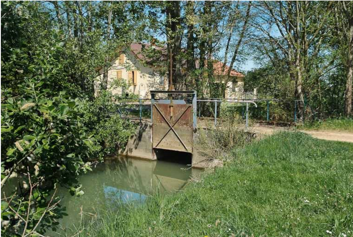
Vue d'ensemble : vanne.
