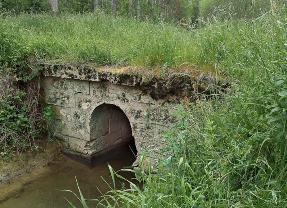
Ponceau, vue rapprochée.
