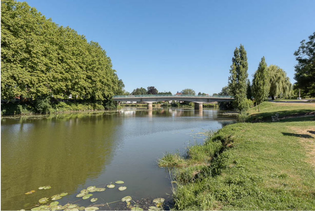
Vue générale du pont et du site.
