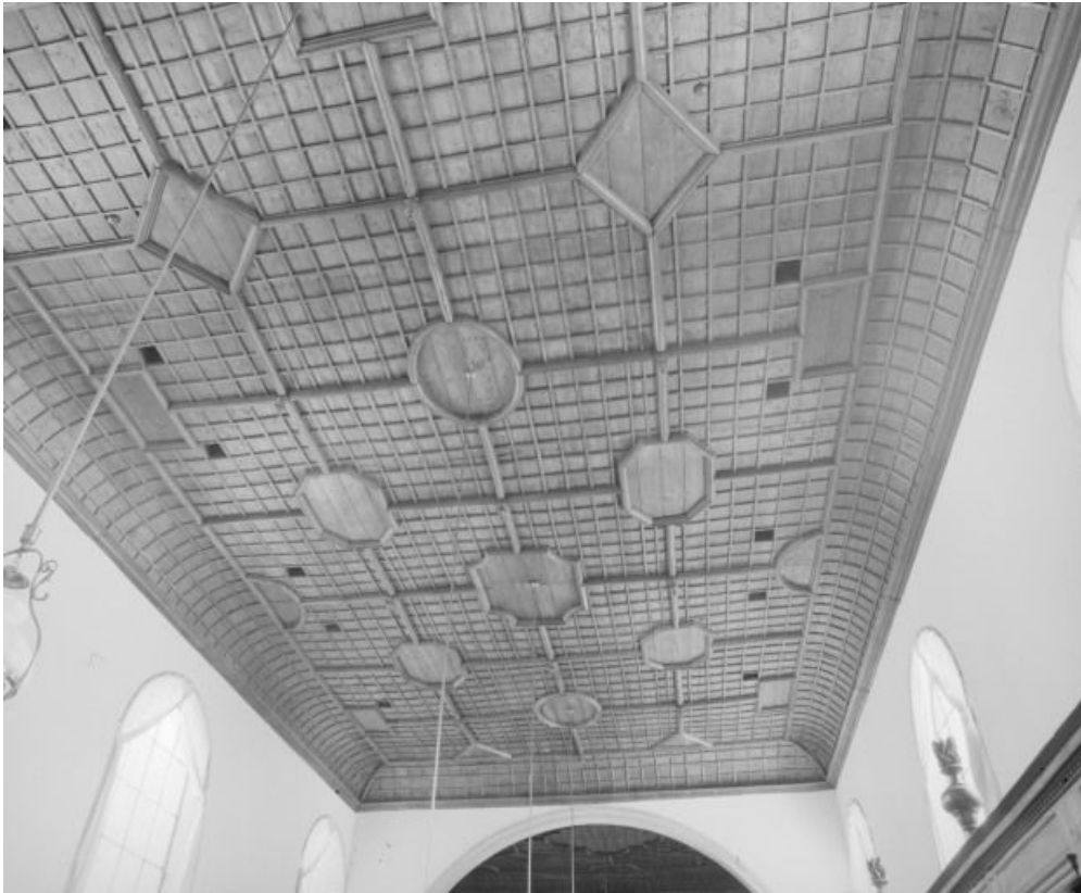
Salle des femmes, vue d'ensemble du plafond.
