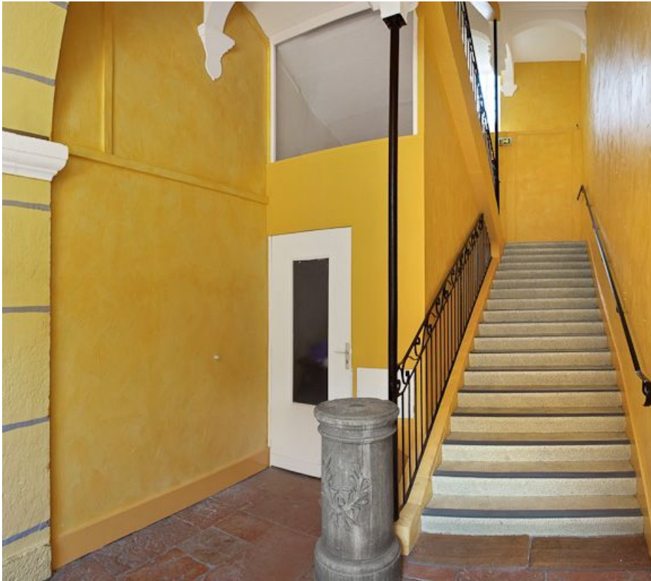
Bâtiment en L, escalier rampe sur rampe.
