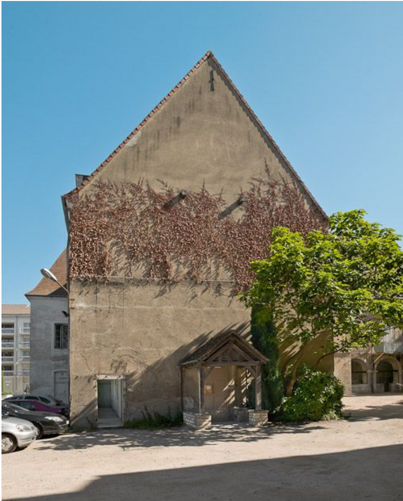
Bâtiment en L, mur-pignon ouest.
