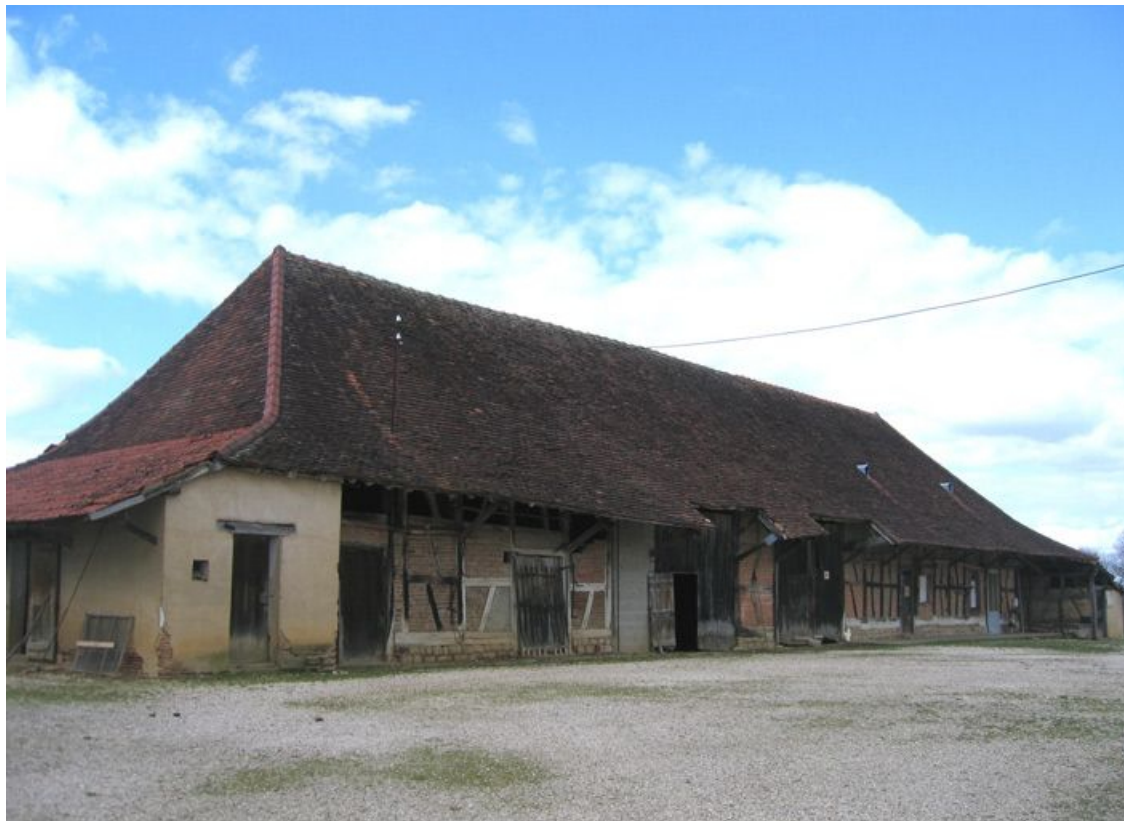
Vue d'ensemble de la façade.
