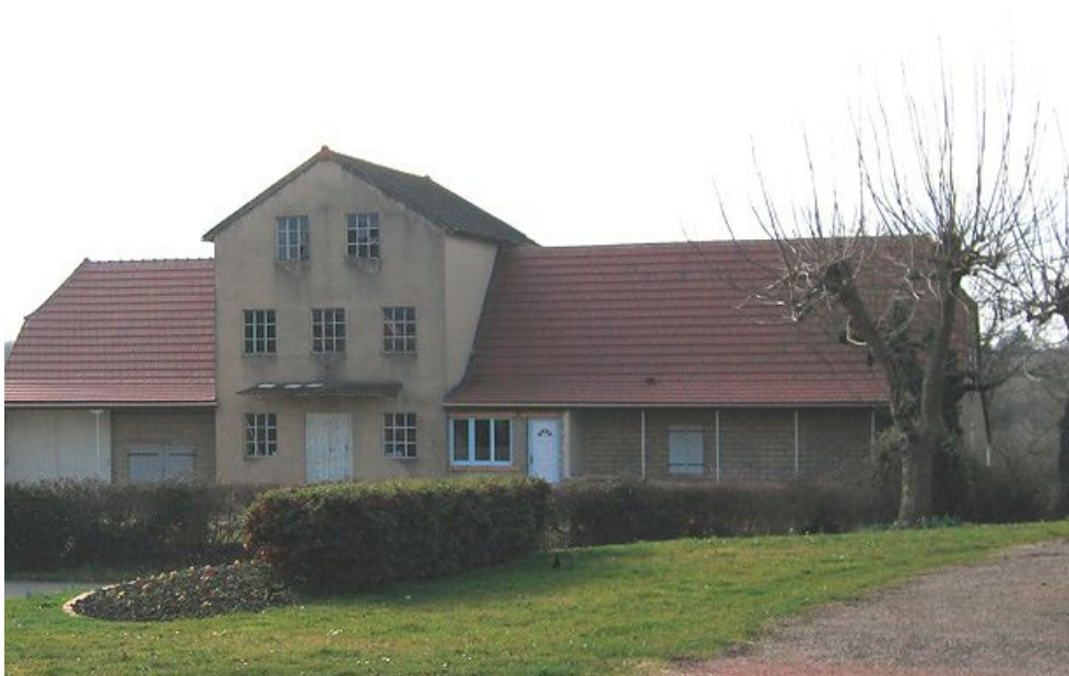
Vue d'ensemble de la façade du moulin.
