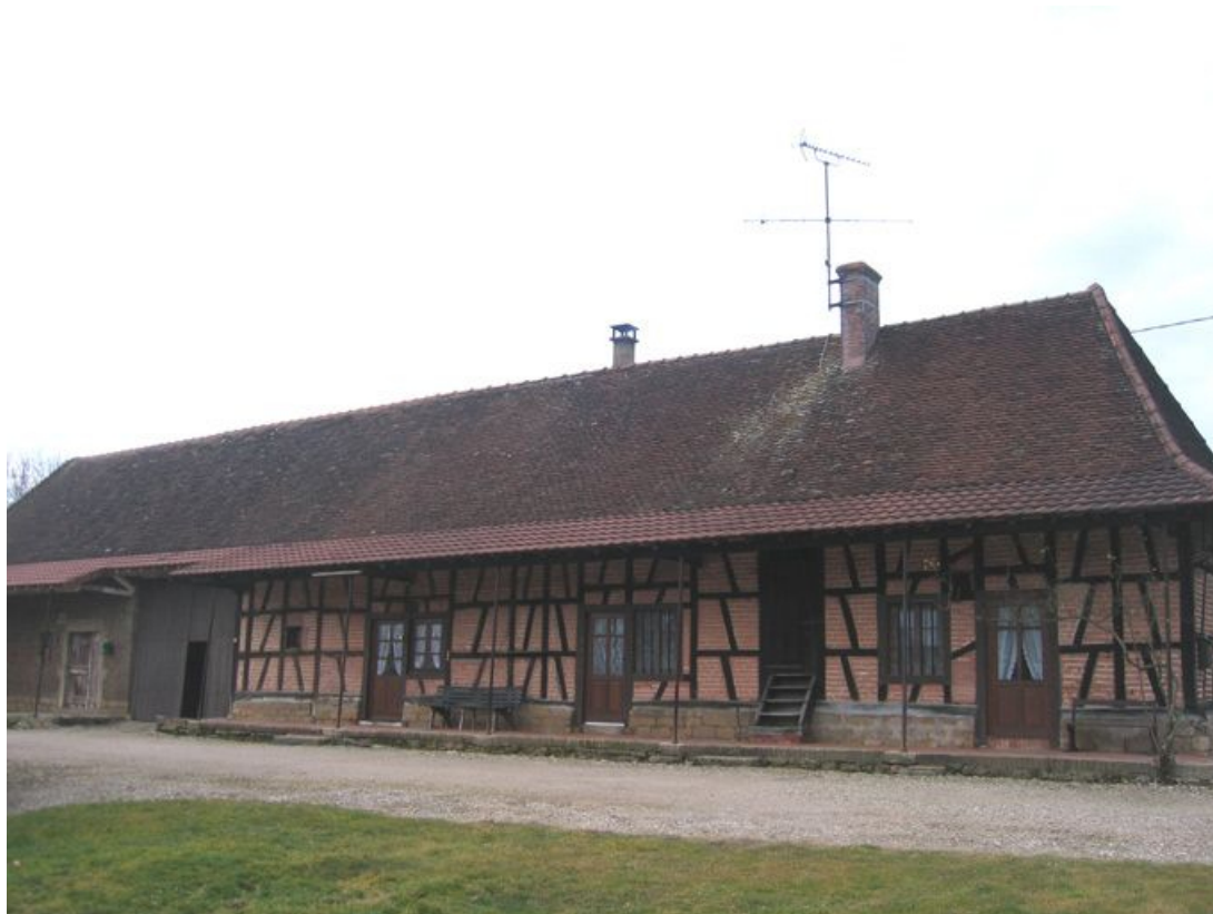
Vue d'ensemble de la façade.
