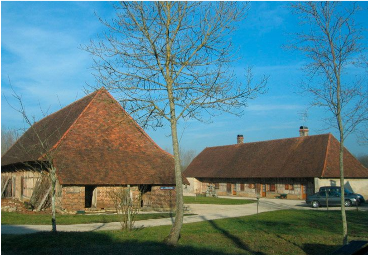
Vue sud de l'ensemble.
