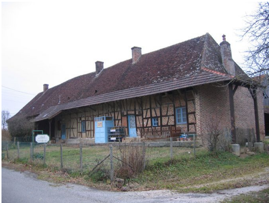
Vue d'ensemble de la façade postérieure.
