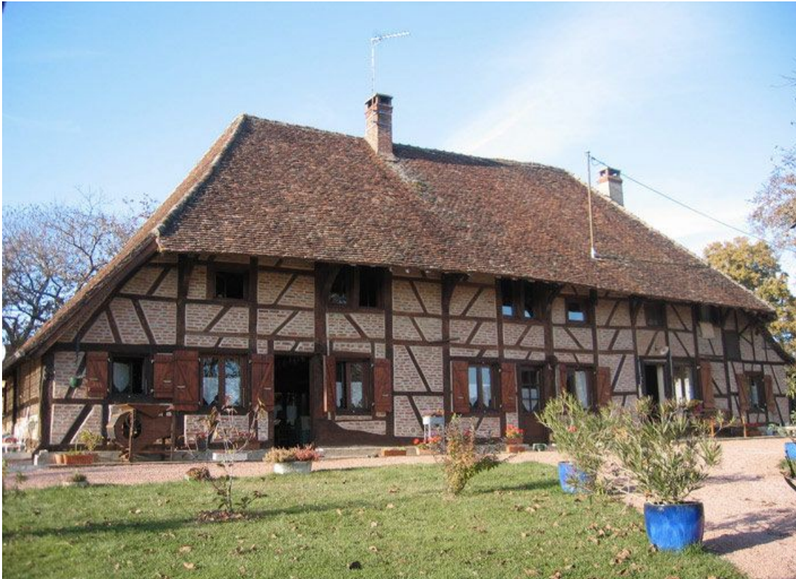
Vue d'ensemble de la façade.
