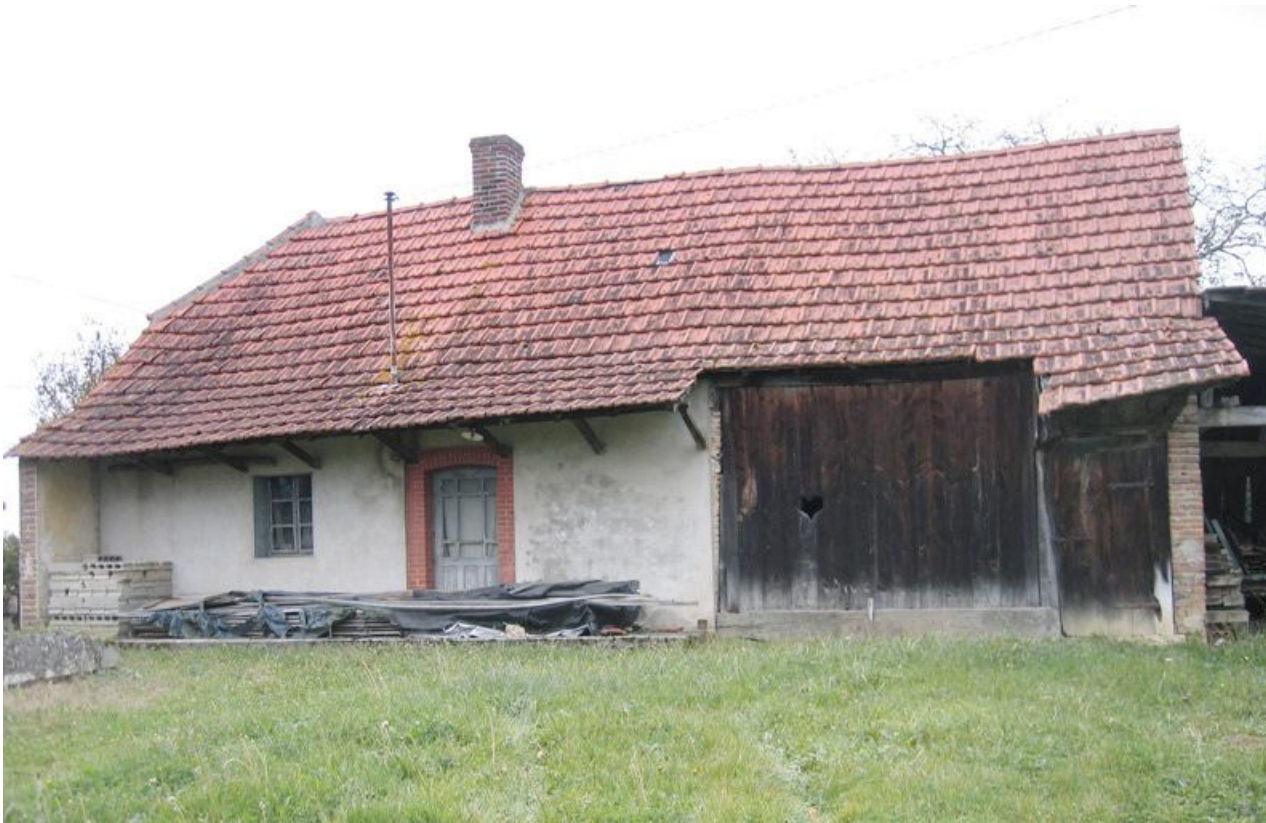
Vue d'ensemble de la façade.
