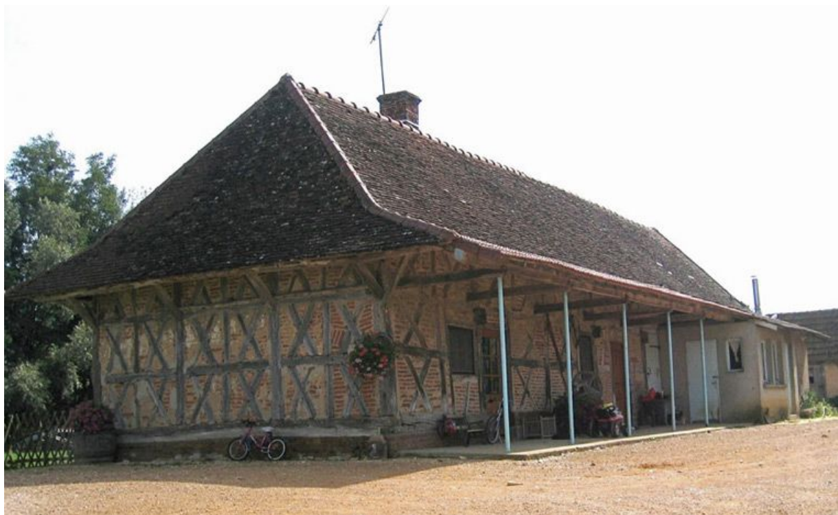
Vue d'ensemble de la façade.
