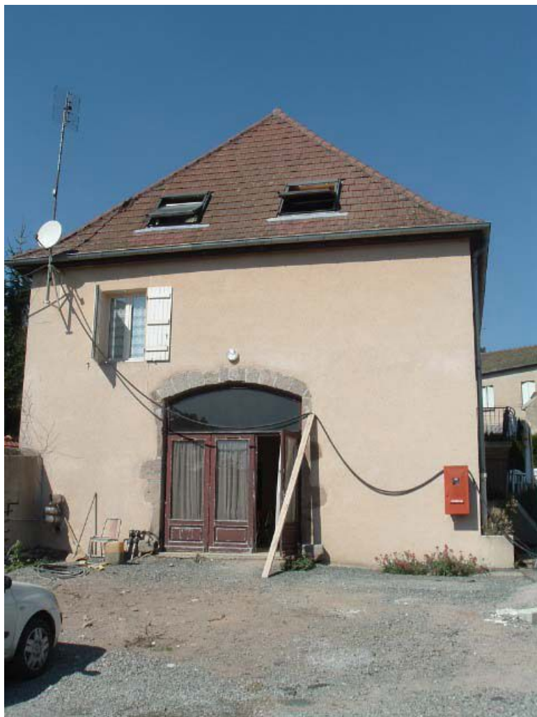
Vue d'ensemble du bâtiment des communs.
