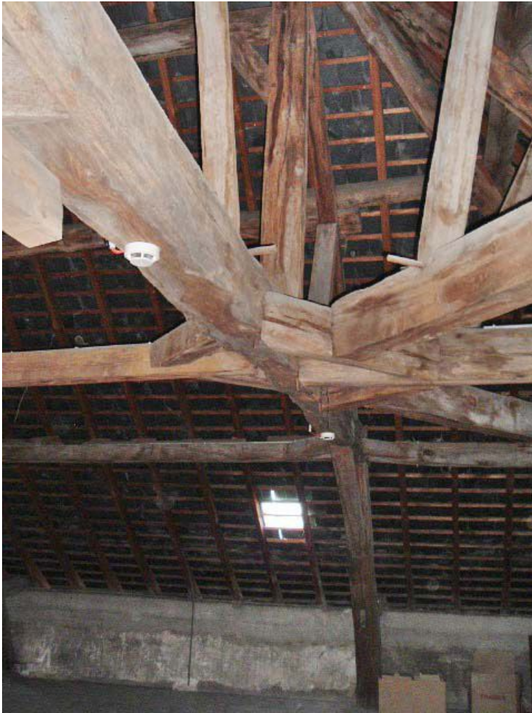
Vue intérieure de la charpente, comble.
