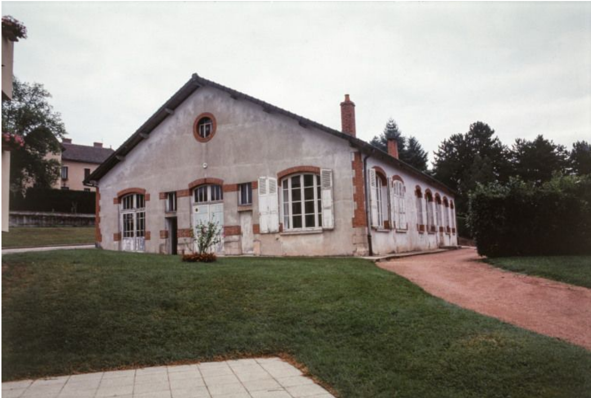
Bâtiment pour les services généraux.
