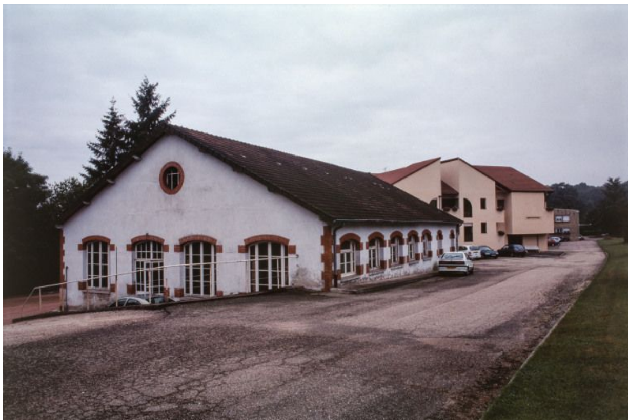
Bâtiment pour les services généraux.
