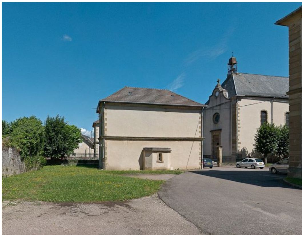
Bâtiment à droite de l'allée et chapelle.
