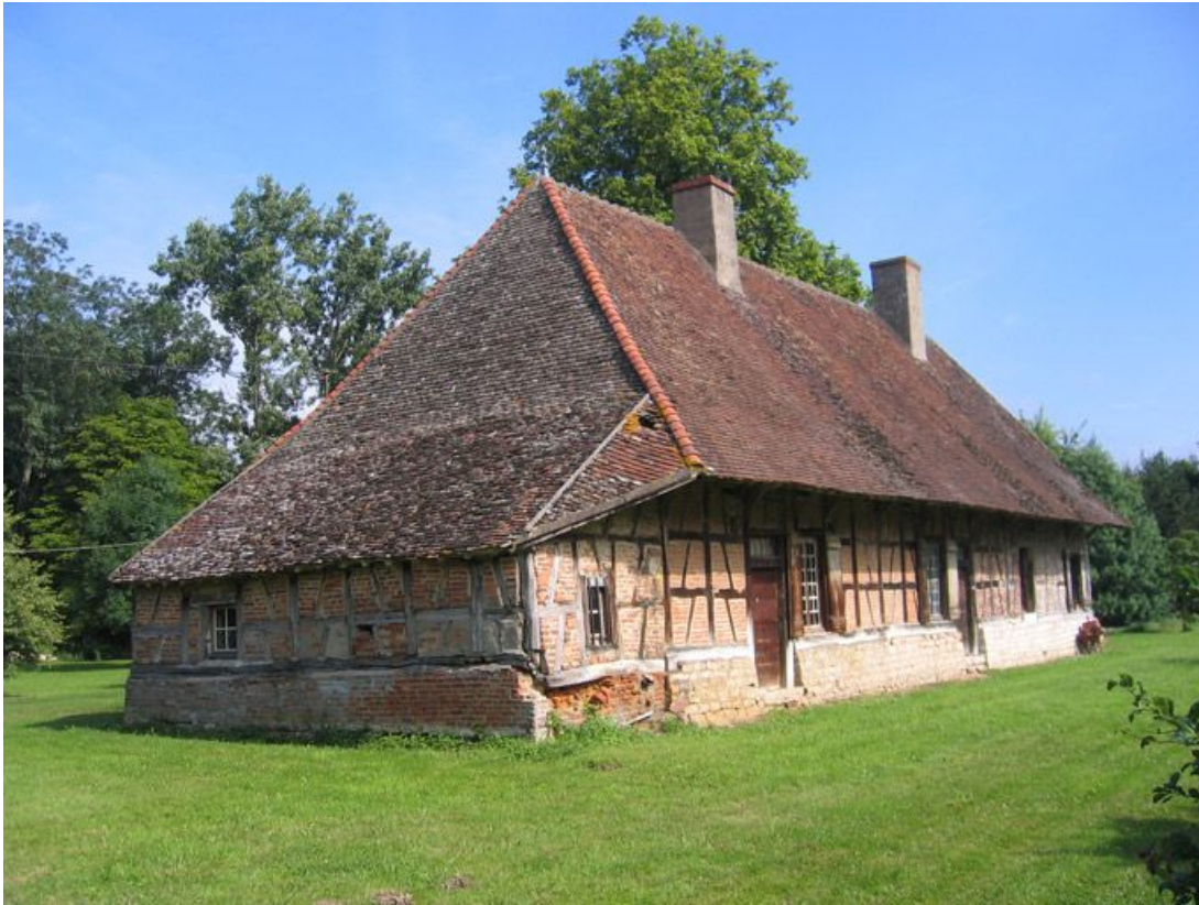
Vue d'ensemble de la façade.
