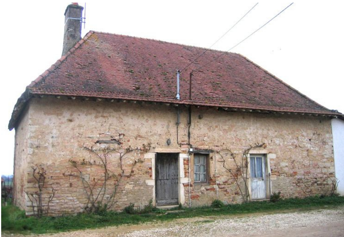
Vue d'ensemble de la façade de l'habitation.
