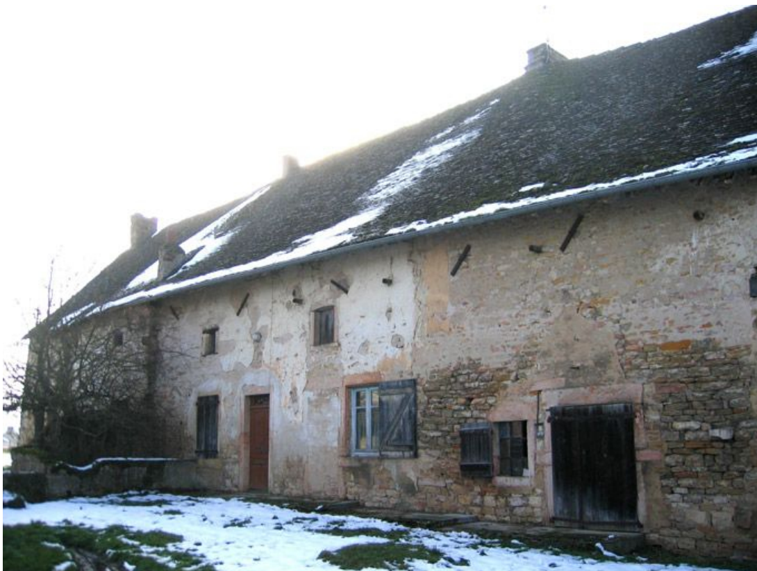
Vue d'ensemble de la façade antérieure.
