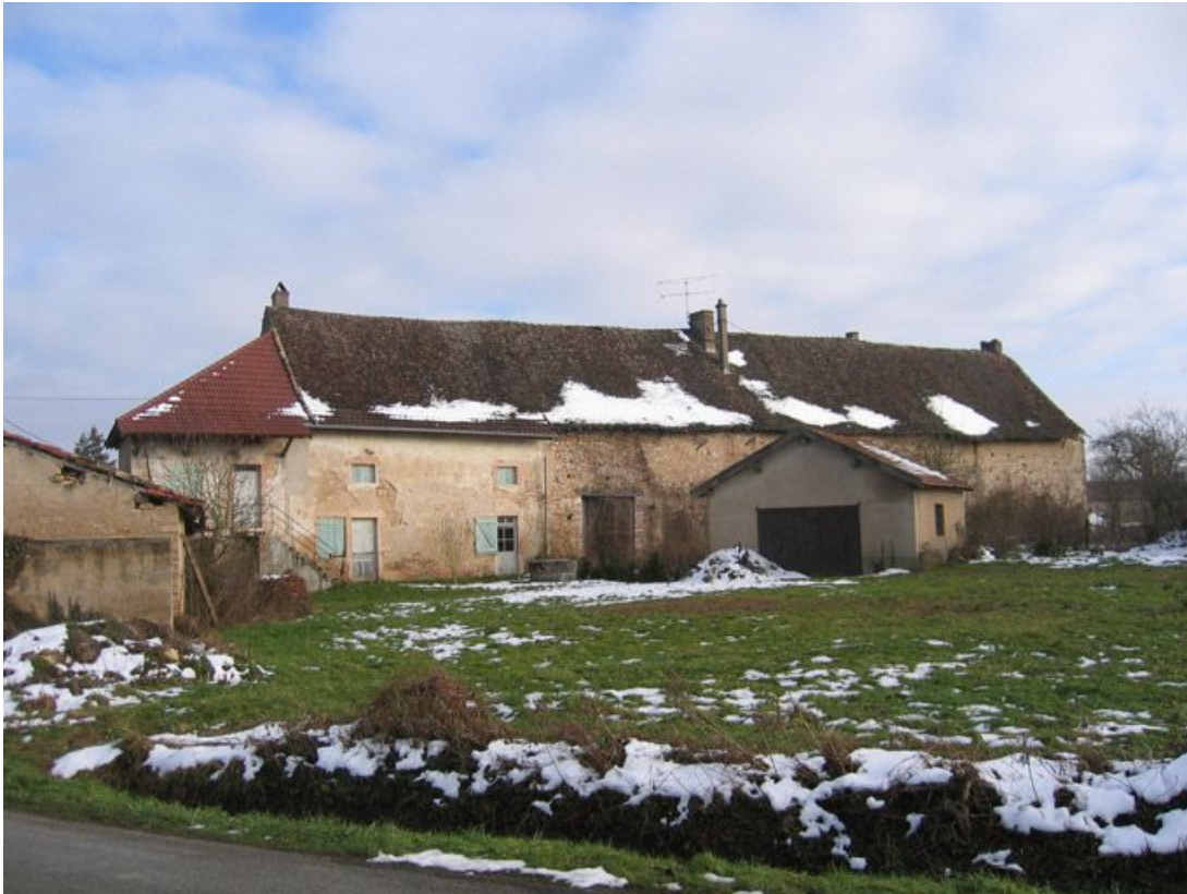
Vue d'ensemble de la façade postérieure. 71, L'Abergement-de-Cuisery
