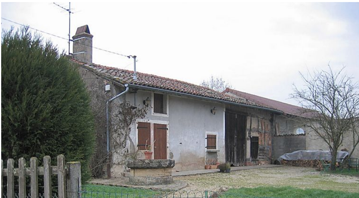
Vue d'ensemble de la façade.
