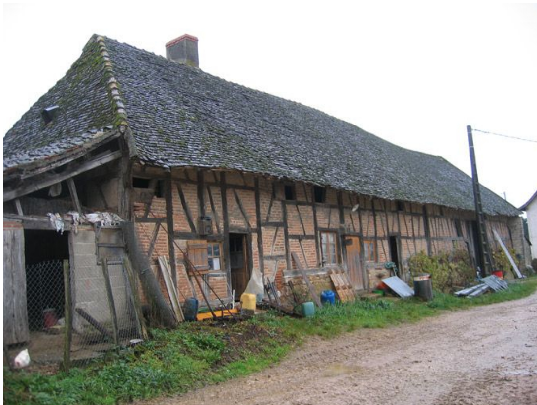
Vue d'ensemble de la façade.
