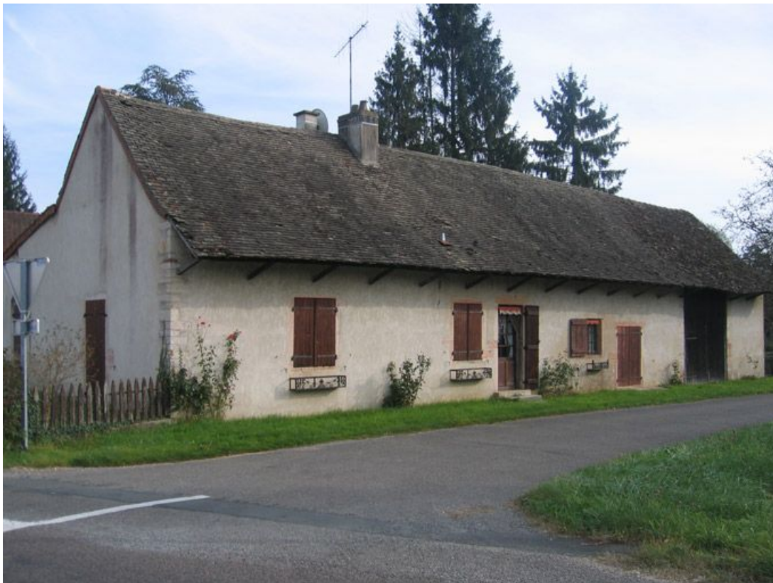
Vue d'ensemble de la façade.
