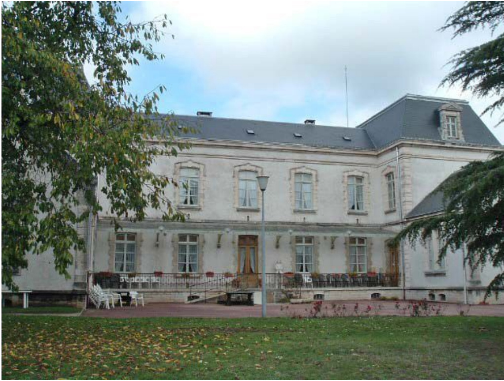
Vue générale de la façade antérieure.
