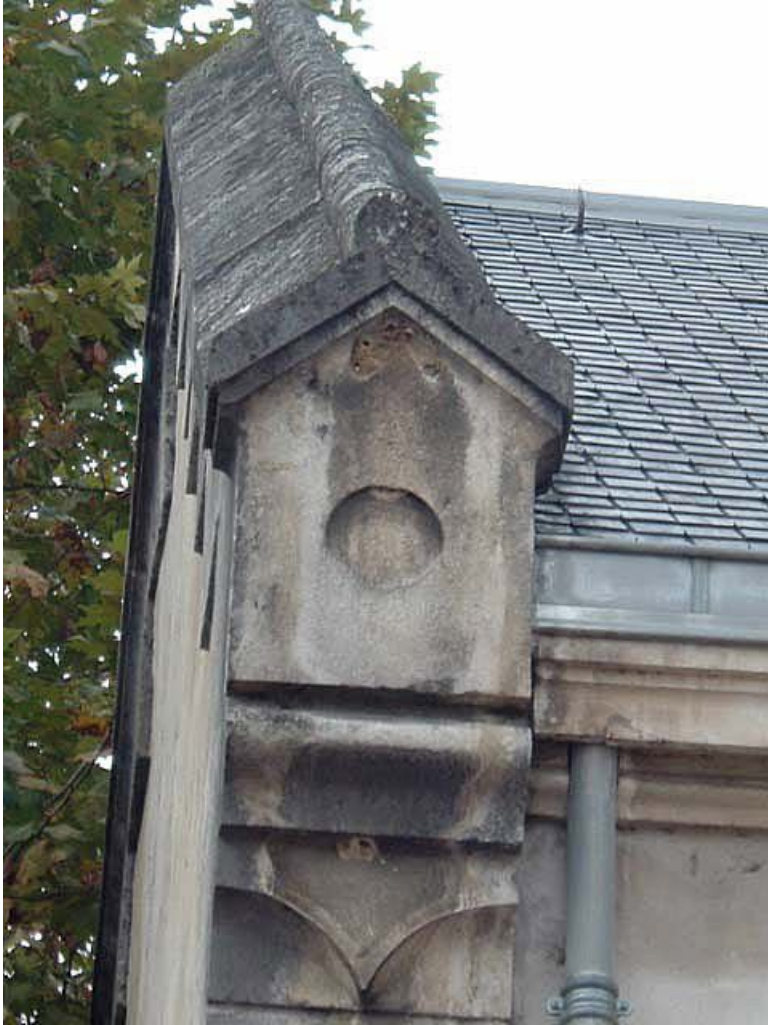
Vue de détail : rampant du pignon découvert.
