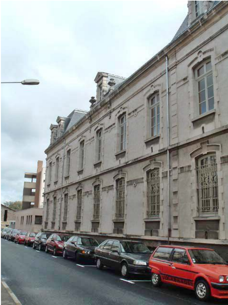
Vue générale latérale de la façade postérieure.
